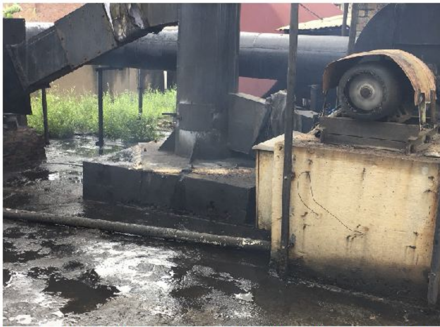
恒昌纸业公司烟囱底座有缺口,排出烟气具有刺激性。
